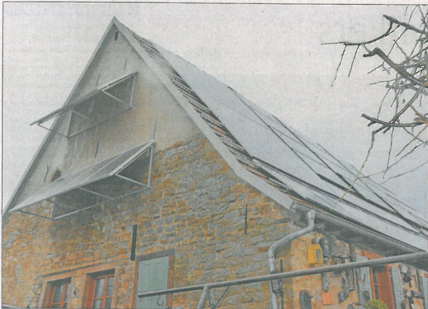
Fast überall auf den Dächern der Familie Müller fangen die Solarmodule Sonnenstrahlen ein. FOTO: SCHMALENBERG
